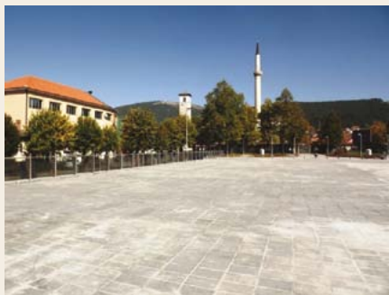
Novi plato u Pljevljima ispod kojeg je parking garaža
