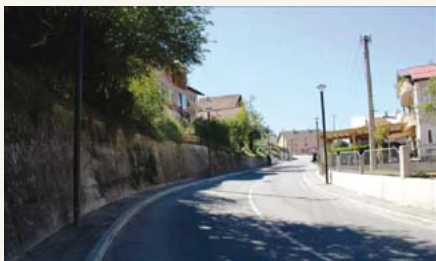
Trotoar sa rasvjetom u ulici Rifata Burdževića u Rožajama
