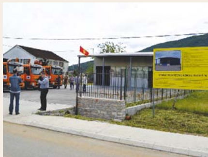
Reciklažno dvorište i vozila za selektivno prikupljanje i odlaganje otpada u Danilovgradu
